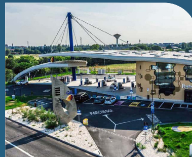
Fornitura di apparecchiature destinate al trattamento dell'acqua sanitaria e circuiti tecnologici di una grande area di servizio Q8.
