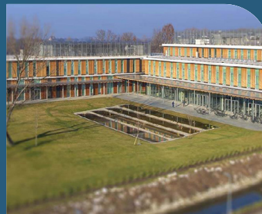
Fornitura apparecchiature progettate per il trattamento a 360° delle acque primarie dell'Università di Lodi
